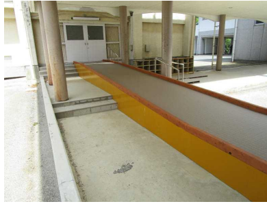
◇体育館への通路の改装◇
